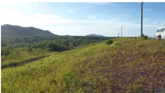
ลาดเขื่อนด้านท้ายน้ำ
