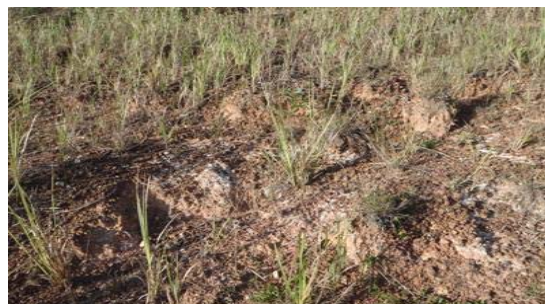
ลาดเขื่อนถูกกัดเซาะ
