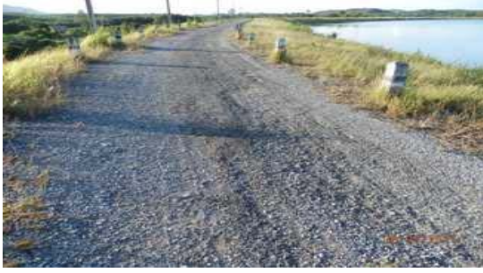
สภาพผิวจราจรถูกกัดเซาะ
