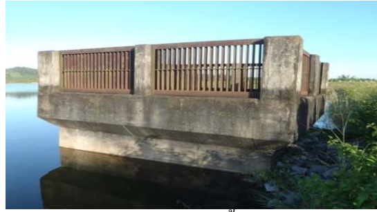
อาคารระบายน้ำล้น
