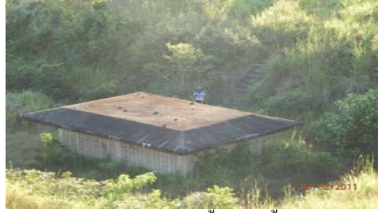
อาคารท่อระบายน้ำลงลำน้ำเดิม
