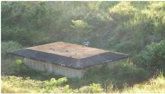
อาคารที่ระบายน้ำลงลำน้ำเดิม
