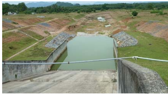
ส่วนสลายพลังงานและคลองระบายน้ำ
