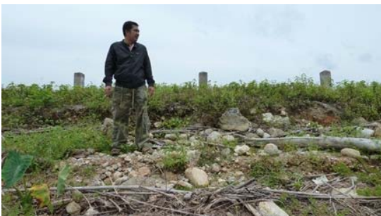
ถูกกัดเซาะเป็นชั้นลึกประมาณ 70 ซม.
