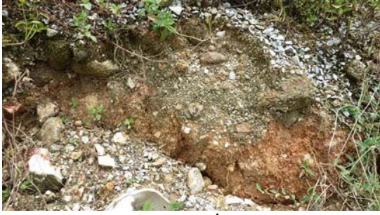
ลักษณะของลาดที่ถูกกัดเซาะ
