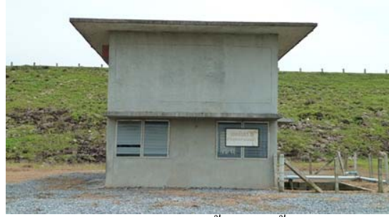
อาคารที่ระบายน้ำลงลำน้ำเดิม
