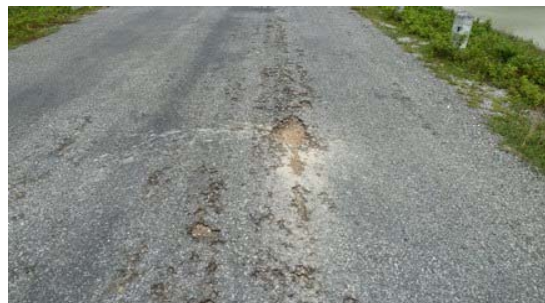
สภาพผิวจราจรถูกกัดเซาะ
