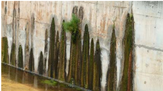
รูระบายน้ำ
