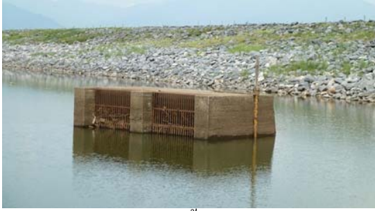
อาคารรับน้ำ (Intake)
