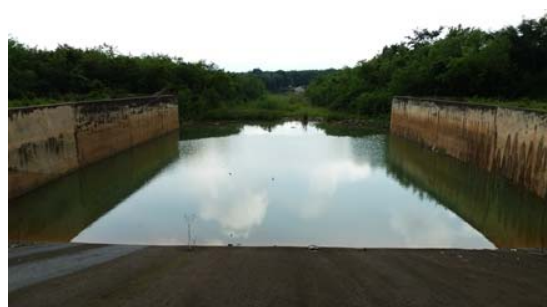
ส่วนสลายพลังงานและคลองระบายน้ำ
