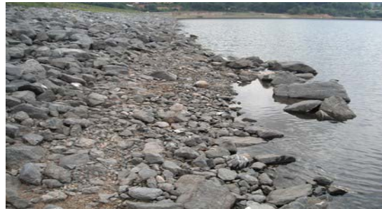
วัสดุป้องกันลาดถูกกัดเซาะ
