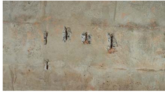
สภาพตอม่อสะพานรถยนต์
