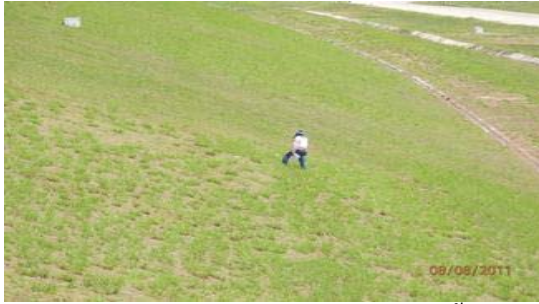
การตรวจสอบสภาพลาดเขื่อนด้านท้ายน้ำ
