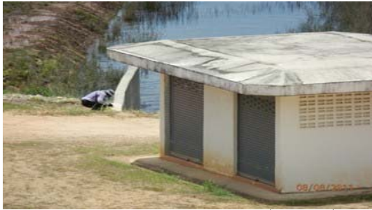
การตรวจสอบอาคารที่ระบายน้ำลงลำน้ำเดิม
