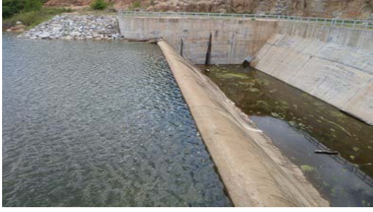
ฝายคอนกรีต
