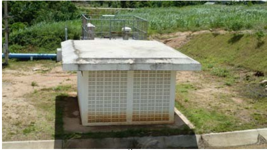
อาคารท่อส่งน้ำเพื่อการประปา
