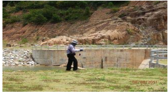
การตรวจสอบอาคารระบายน้ำล้น
