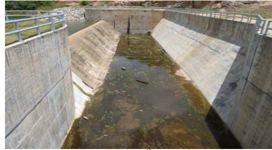
อาคารระบายน้ำล้นใช้งาน
