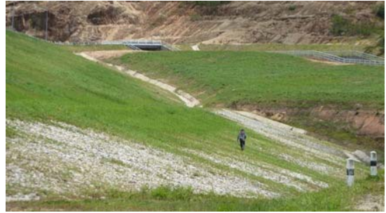
การตรวจสอบสภาพฐานเขื่อน
