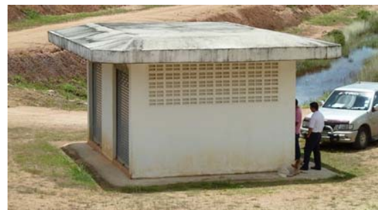
อาคารท่อระบายน้ำลงลำน้ำเดิม
